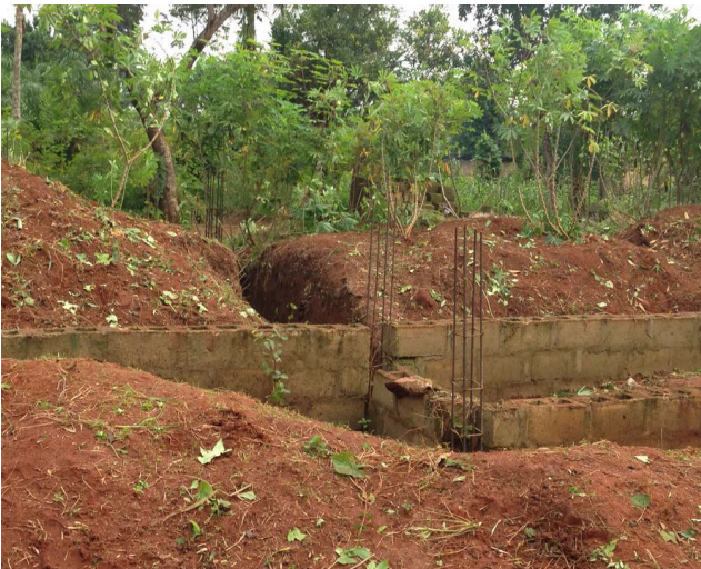
Bauarbeiten im zukünftigen Dorfzentrum
